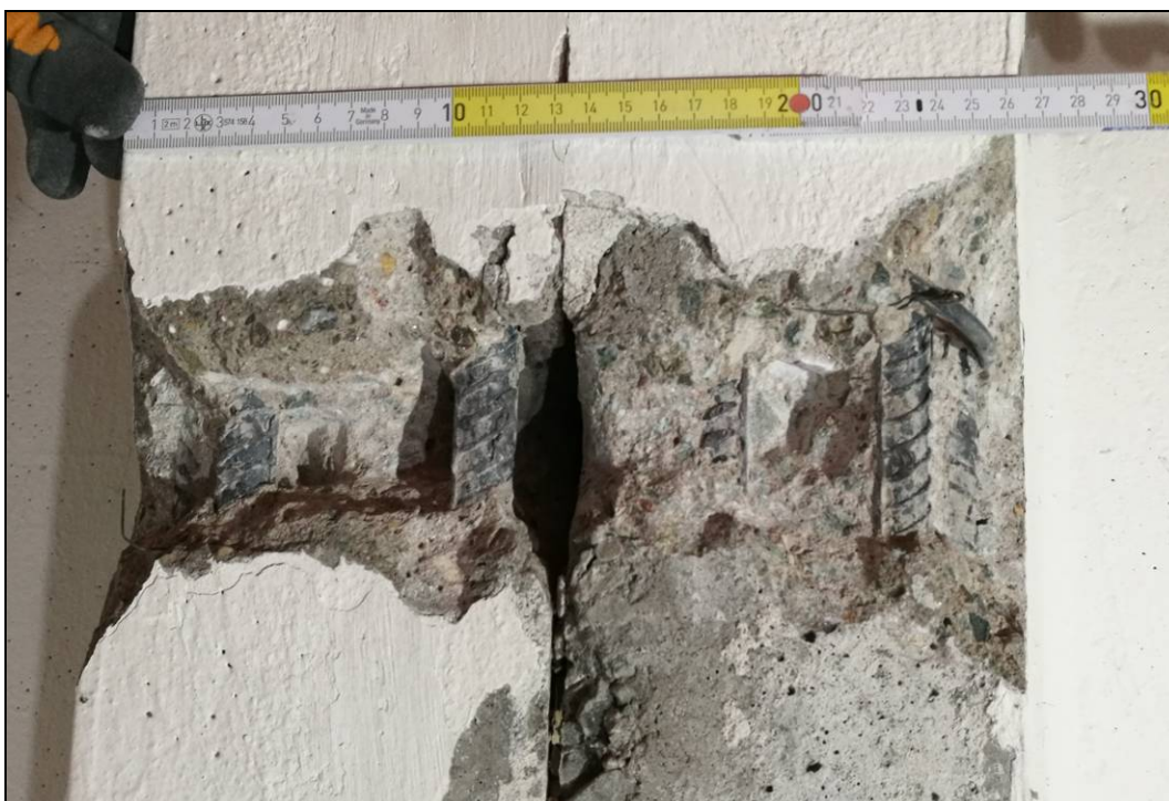
Obr. č. 9 - bouraná sonda BS3 do ŽB prefa nosníku (spodní líc hlavních trámů) nad. 1. PP
