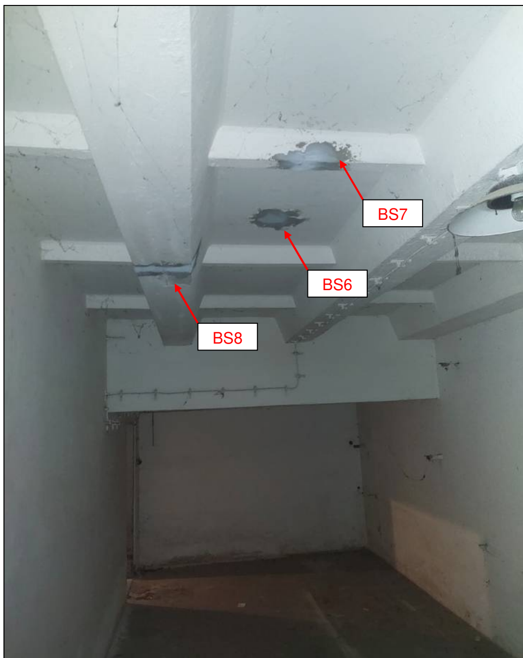
Obr. č. 15 - pohled na strop 1. PP - ŽB prefa nosníky (ve schématu řez 1-1')
