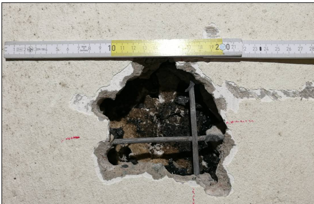
Obr. č. 7 - sonda BS1 do desky ŽB prefra nosníku - nad deskou byla zastižena tepelná izolace z polystyrenu, která se nachází pod chladničkou v 1. NP
