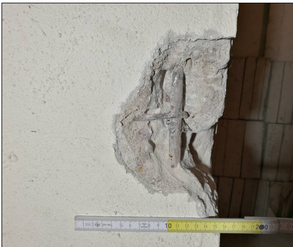
Obr. č. 4 - Bouraná sonda BS4 do sloupu v 1. PP
