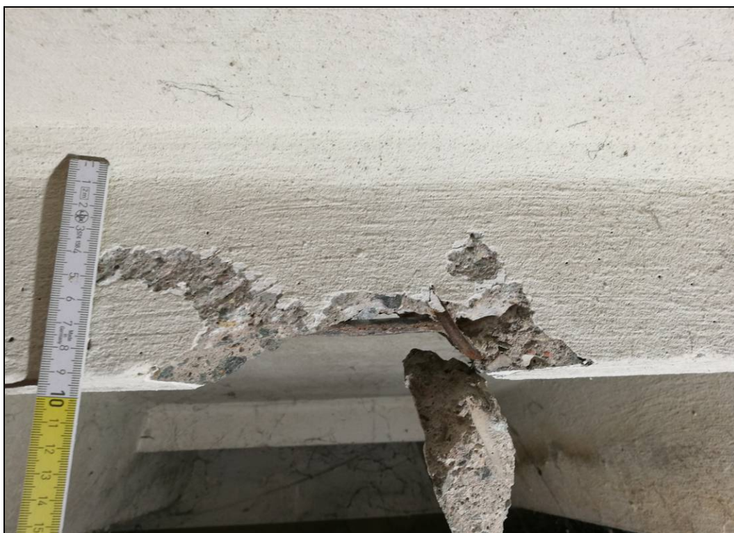
Obr. č. 6 - bouraná sonda BS2 do žebra ŽB prefa nosníku nad 1. PP
