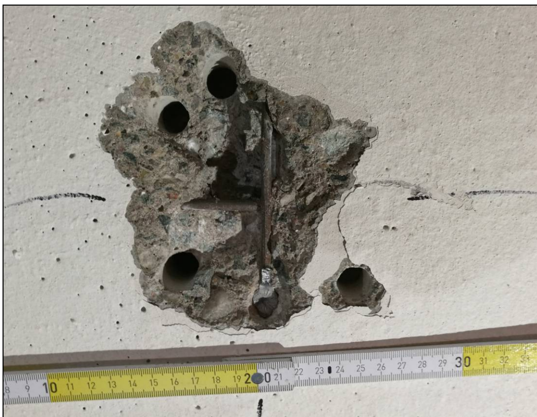
Obr. č. 11 - bouraná sonda BS7 do desky ŽB prefa nosníku
