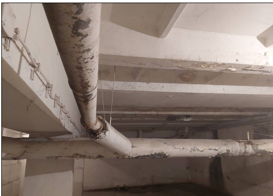
Obr. č. 17 - pohled na strop v 1.PP - tvořený ŽB deskou s nosníky a žebry
