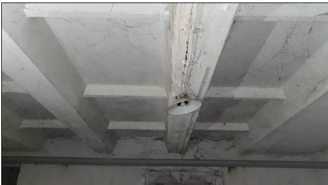
Obr. č. 18 - pohled na strop 1.PP - tvořený ŽB deskou s nosníky a žebry (řez 1-1')
