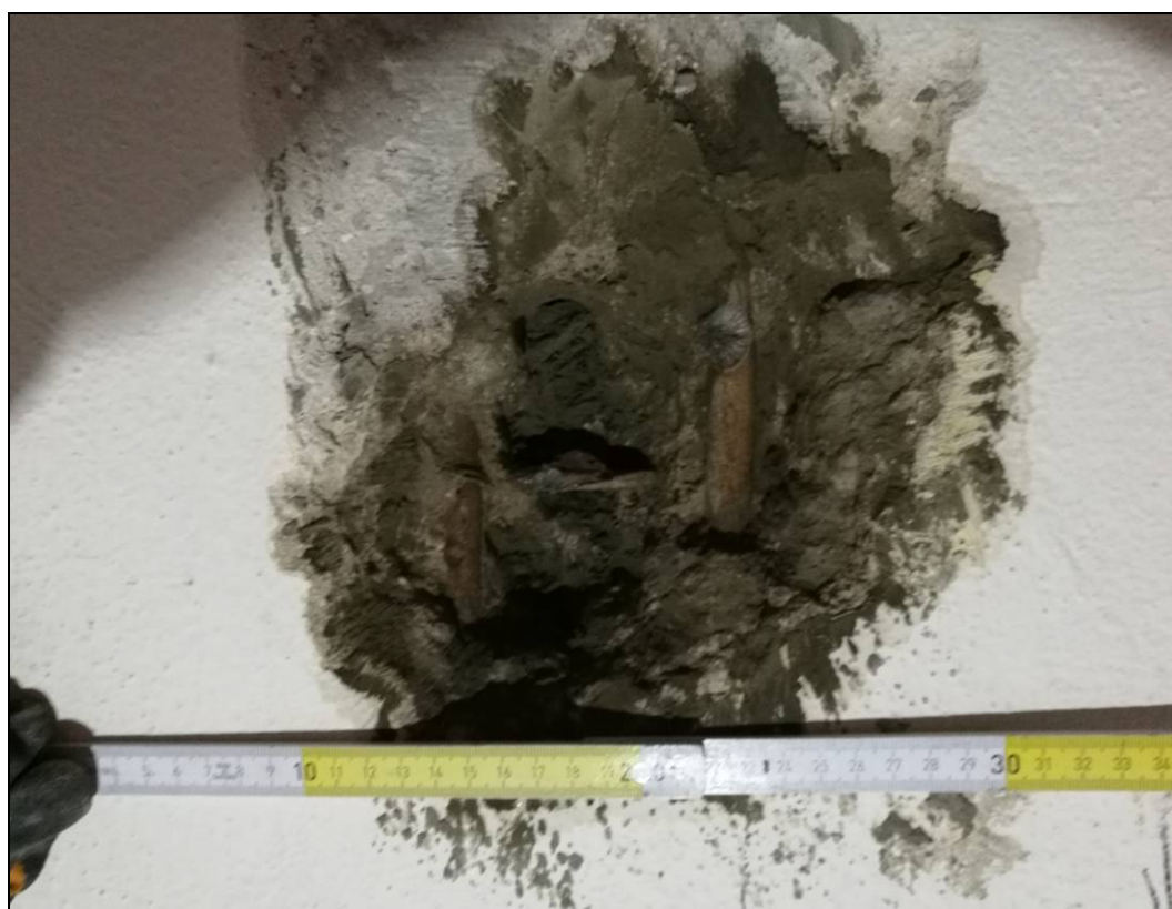
Obr. č. 12 - bouraná sonda BS9 do spodního líce stropní desky nad 1. NP
