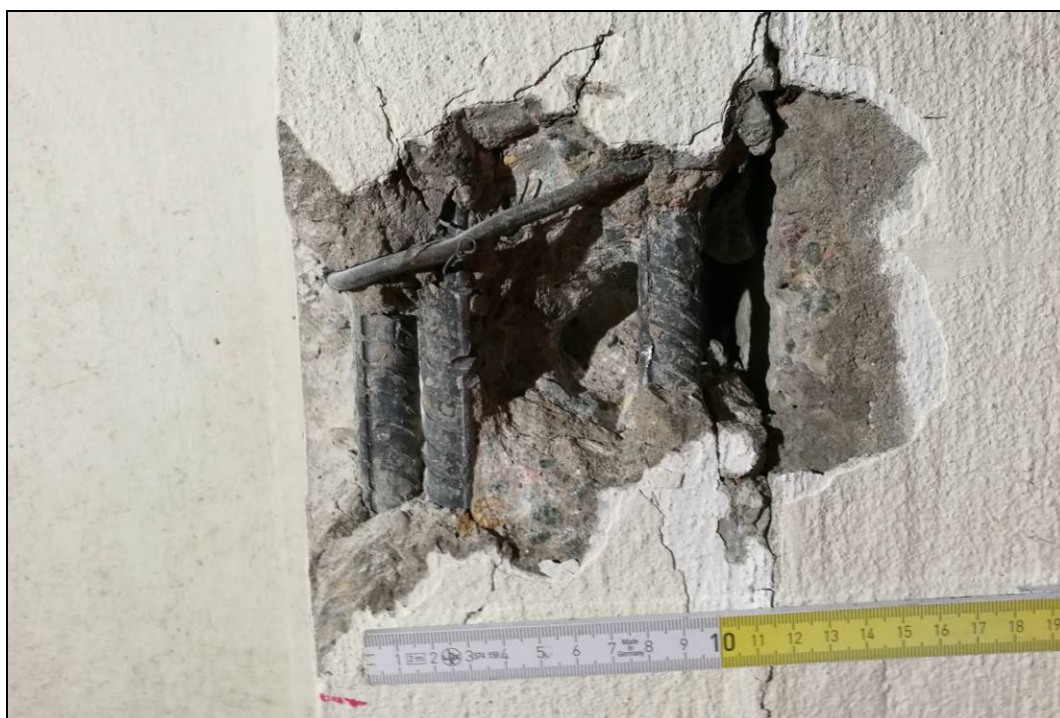
Obr. č. 5 - bouraná sonda BS8 do ŽB prefa nosníku (spodní líc hlavního trámu) nad. 1. PP
